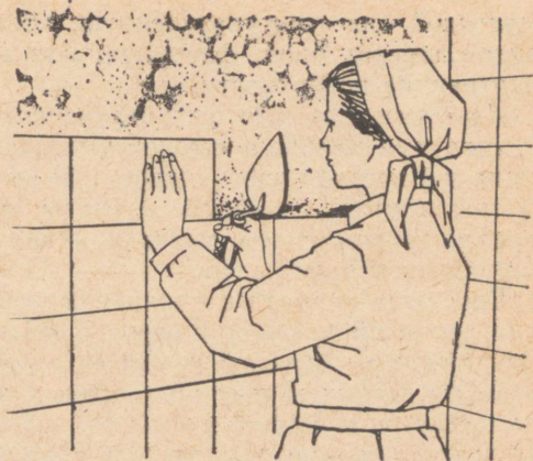
Рис. 37. Укладка глазурованных плиток.
