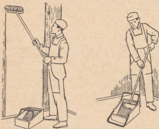
Рис. 16. Окраска поверхностей валиком на длинной ручке.
