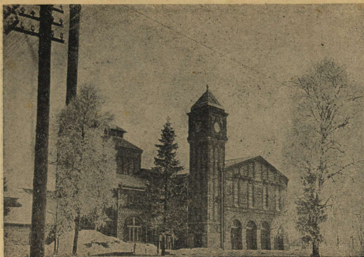
70. joonis. Ellamaa elektrijaam.
