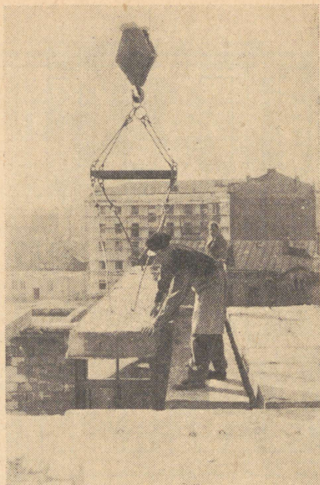
Laepaneeli monteerimine tornkraana CBK-1 abil.
