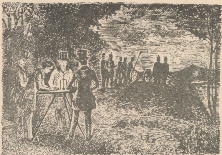
Joon. 158. Vanaaegne gravüür, mis kujutab häälnagu levimise kiiruse määramist õhus.
