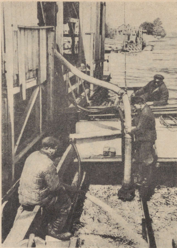
Joon. 63. Kala vastuvõtmine kalapumba abil. Paadis olevatele kaladele lastakse voolikuga vett. Paati on juba ulatatud kalapumba jäme voolik.
