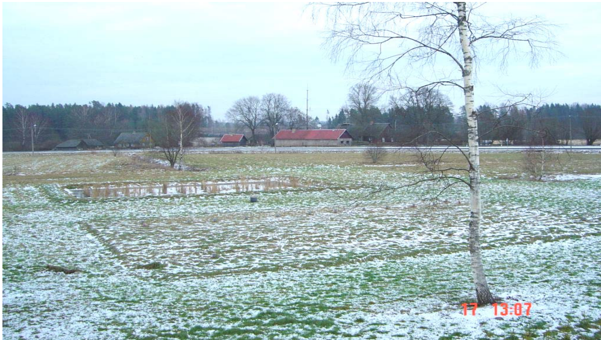
Joonis 3. Paistu märjalapuhasti üldvaade 17. jaanuaril 2004. Esiplaanil on murukihiga kaetud vertikaalfilter, selle järel pilliroostikutega horisontaalfilter, kaugemal paistab äravoolukraav.
