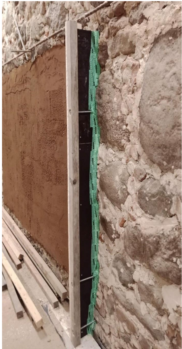
Foto 13 Katsetarindi külgraketis on fikseeritud äärmise posti külge, kiilutud tihedalt maakiviseina vastu ning vineeri ja maakivi vahelised tühimikud kaetud niiskuskindla teibiga
