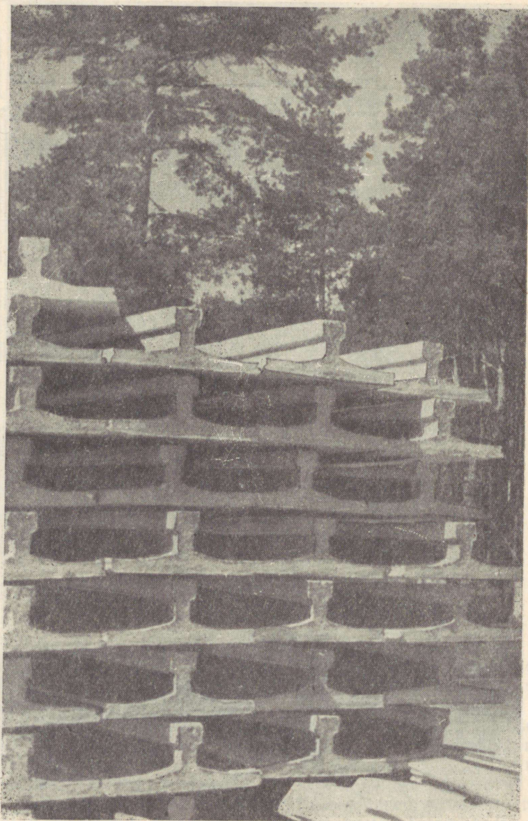
Joonis 40. Rootsi-tüüpi vahelae raudbetoonist katted.
