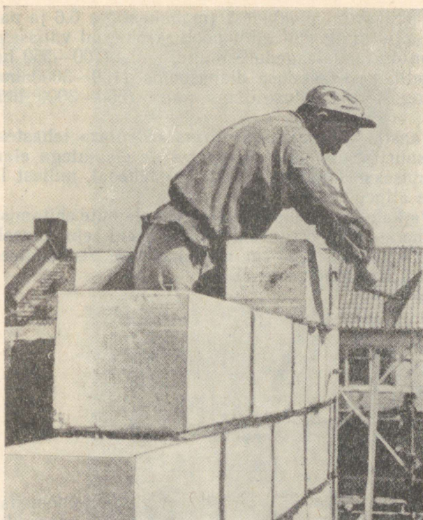
Joonis 7. Gaasbetoonplokkidest seinte ladumine.
