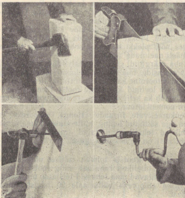
Joonis 6 Gaasbetoon- plokki töötlemine ehitusplatsil.
