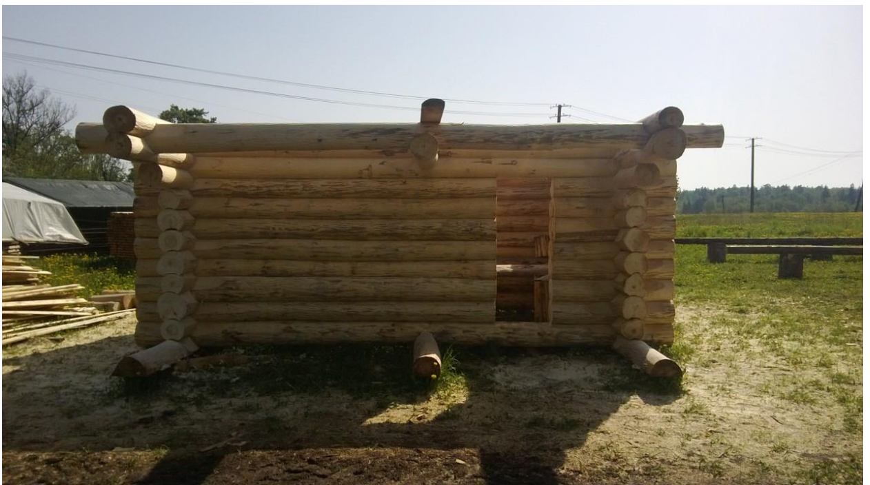
Foto 28 Ukseava lõigatakse õigesse mõõtu siis, kui selgub akna ja ukse laius (19.05.14)
