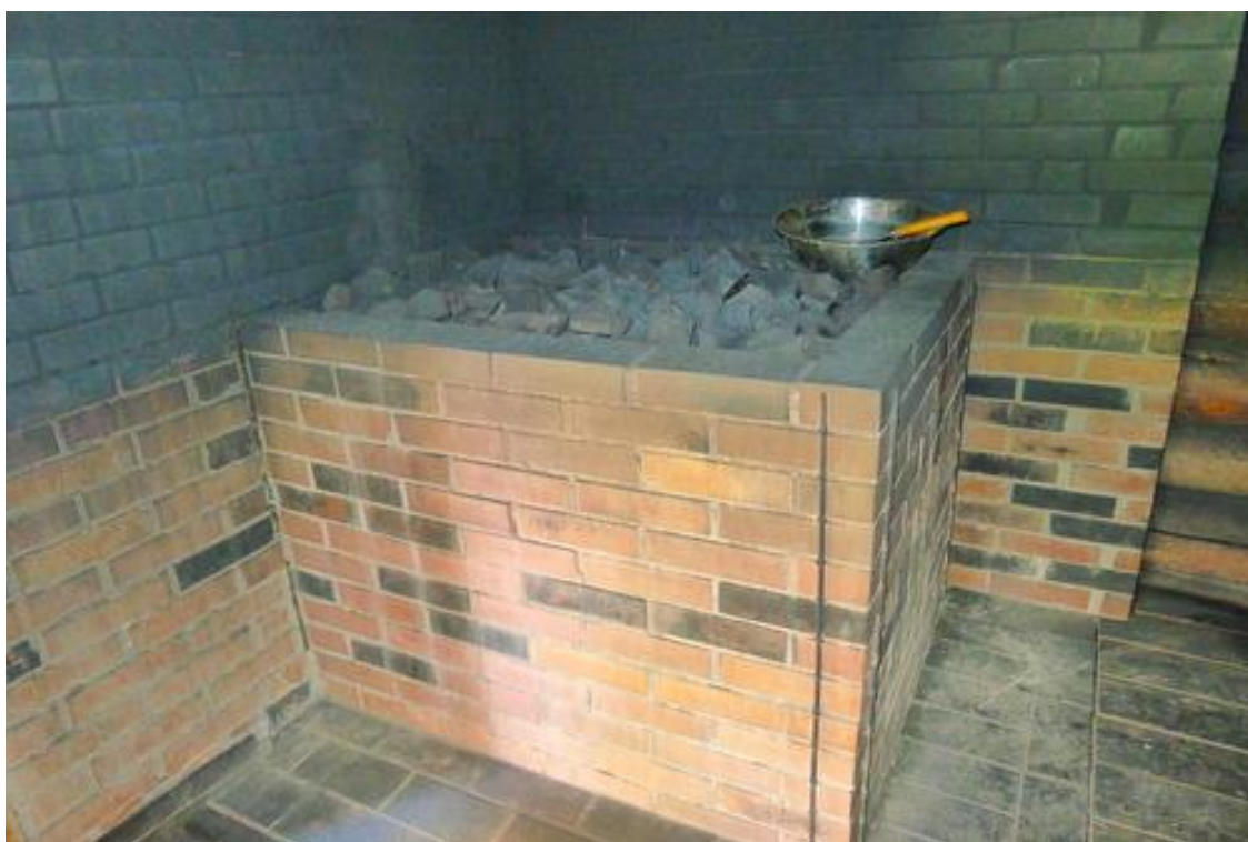
Foto 9 Vaade kastkerisele lavaruumist (29.08.13)
