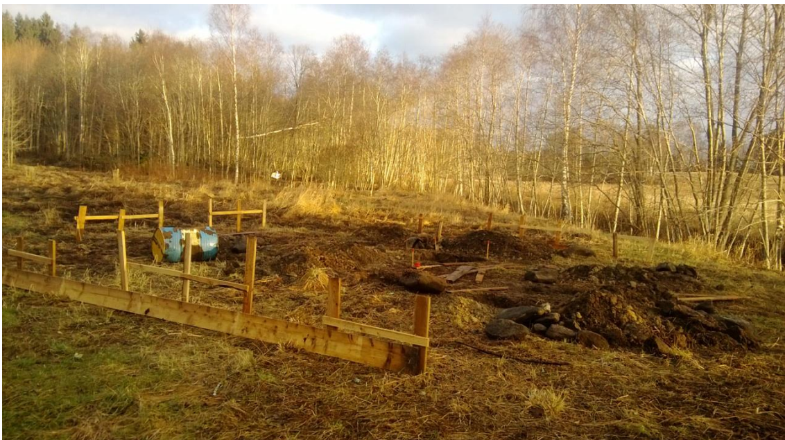
Foto 11 Nahka talu territooriumile on märketarade ja vaiade abil märgitud saunavundament, mille jaoks on osaliselt valmis kaevatud augud. (31.12.13)
