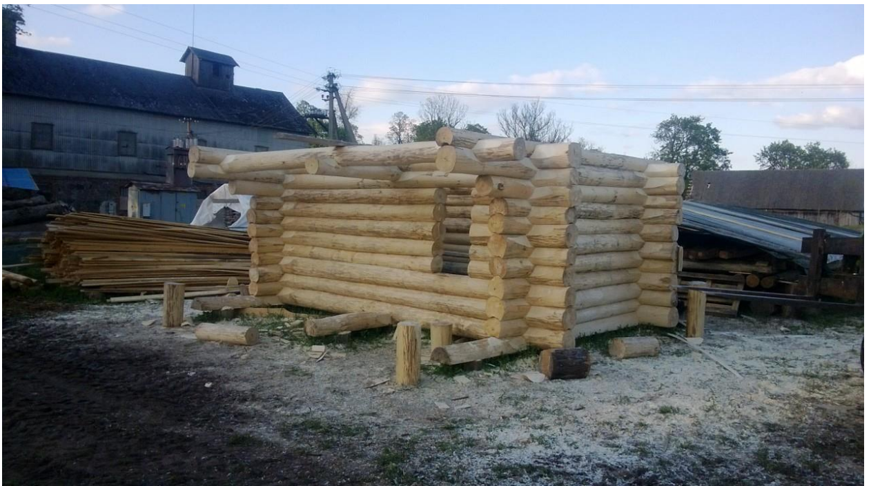
Foto 27 Viimased palgid on paigaldatud, uks veel välja lõigata. (14.05.14)
