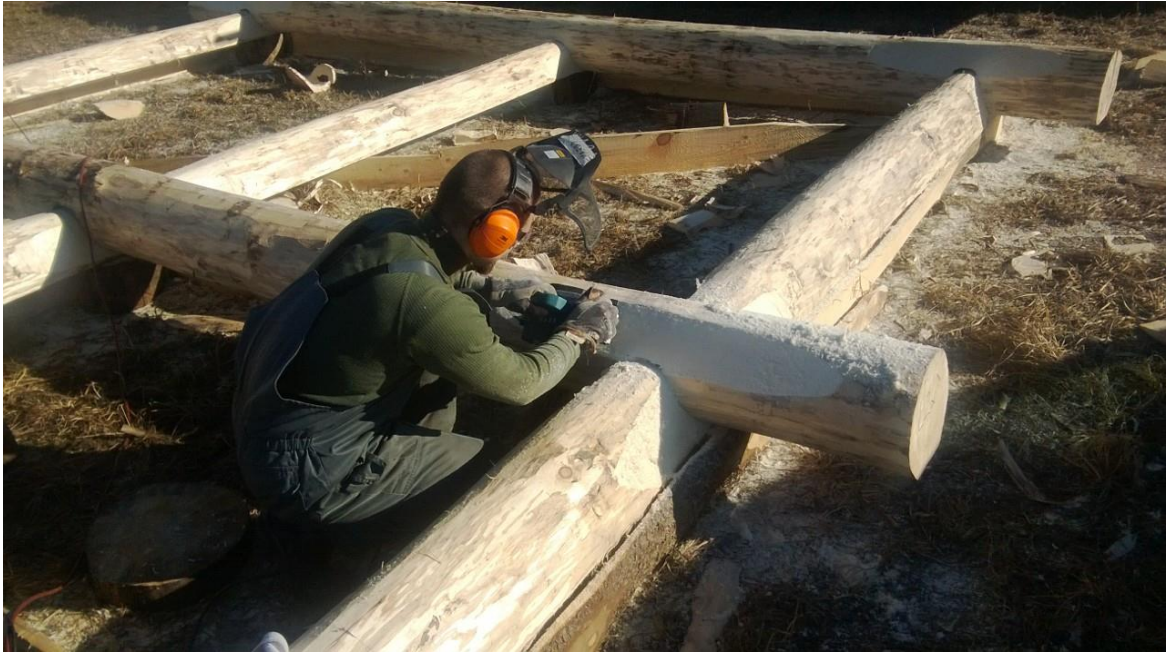
Foto 17 Tapi pealmise poole viimistlemine alguses kumera tallaga elektrihöövliga... (11.03.14)
