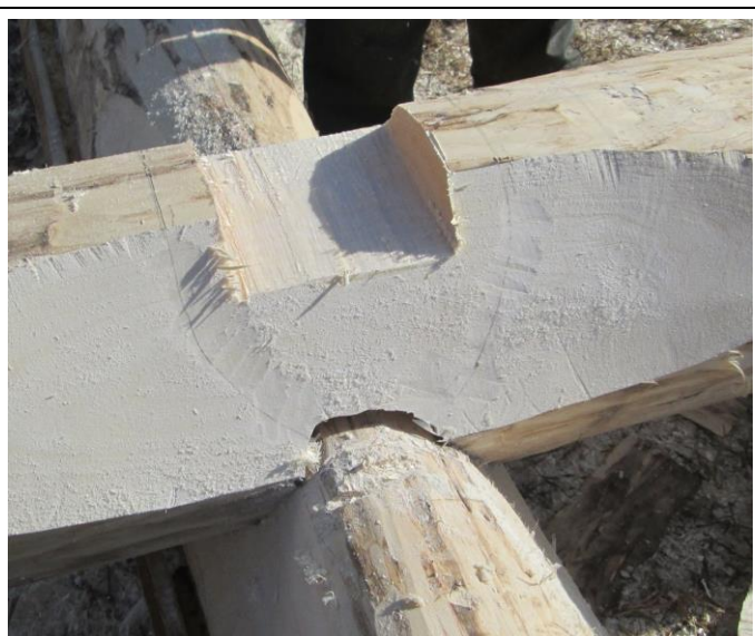
Joonis 9 Tapijoon alumise palgi põsel (Autori foto)
