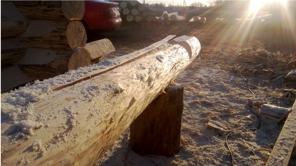
Foto 19 Pooleldi väljalõigatud vara on sisepingete tõttu üles tõusnud (09.04.14)
