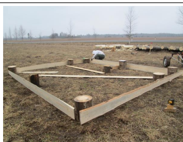
Joonis 3 Aluspakkude fikseerimine Loodil (Autori foto)
