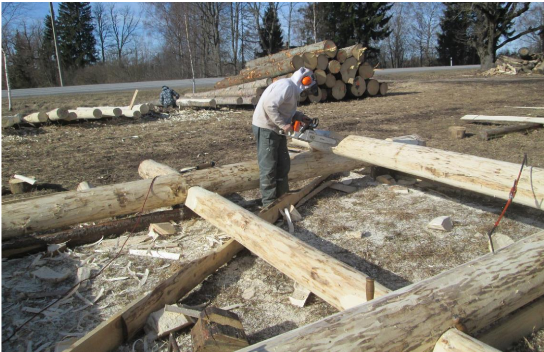
Foto 16 Esimese palgirea viimase tapi lõikamine. (09.03.14)
