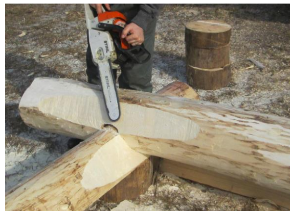
Joonis 5 Kanada sadultapi põse silumine (Autori foto)
