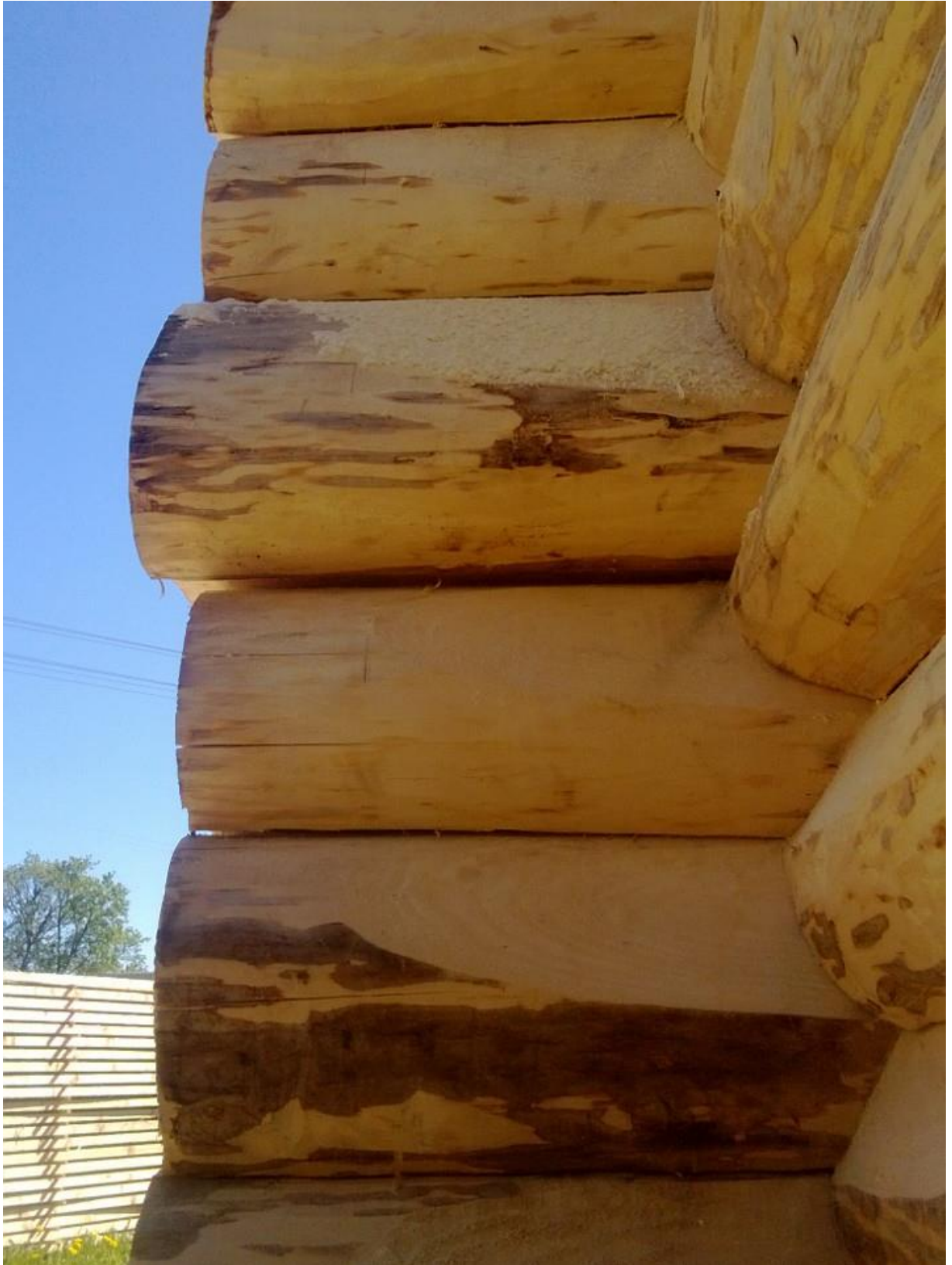
Foto 25 Pähikute varad on sisepingete vabanemise tõttu kiiljad ja erineva vahega (10.05.14)
