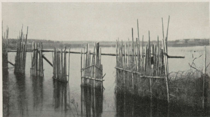
Pilt 100. Tõke , osalt punutud, osalt sõlgede külge seotud tarjadega.
