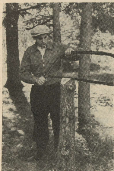
Joon. 41. Teritamispuki valmistamine kõrgelt saetud kännust.
