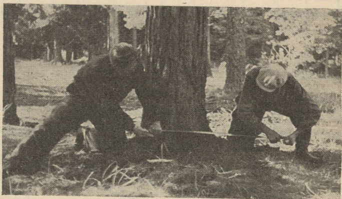
Joon. 10. Kahemehesae abil puu langetamine.
