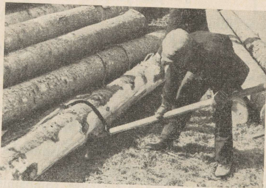
Joon. 113. Palgi pööramine pööramishaagiga.
