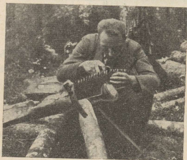
Joon. 43. Saagimispuki kasutamine terituspukina.
