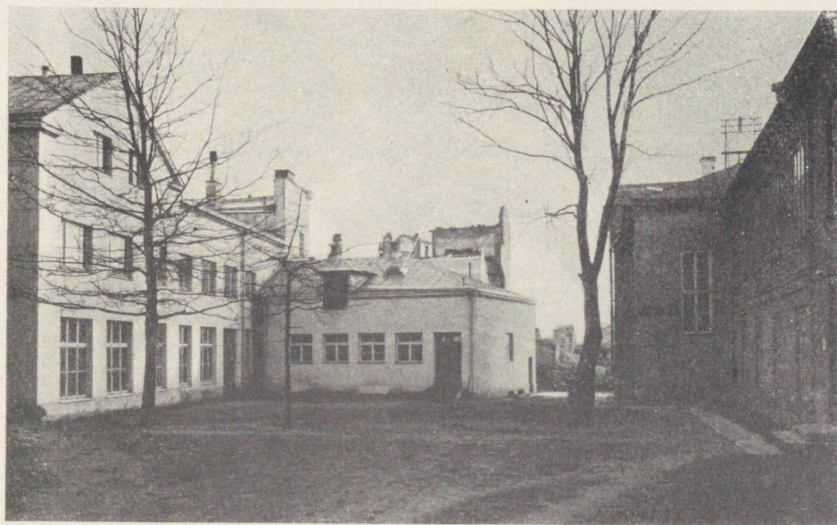
Tahvel VIII. Ulal — loomatervishoiu kateedri hoone kirurgiakorpuse katuselt vaadatuna. Hoone on valminud 1917. aastal. Allkorrus kivist, II korrus puust. Praegu üleni krohvkat- tes. All — kirurgiakliiniku õu 1941. aastal. Keskel asuvale kliiniku statsioonarile ehitati kuuekümnendatel aastatel II korrusena suur auditoorium. Foonil (üle stationaari katuse) on näha peahoone varemed.
