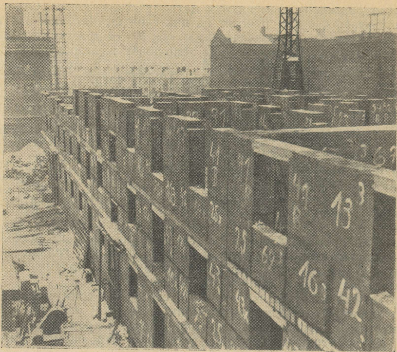
Рис. 119. Строительство жилого дома из блоков.
