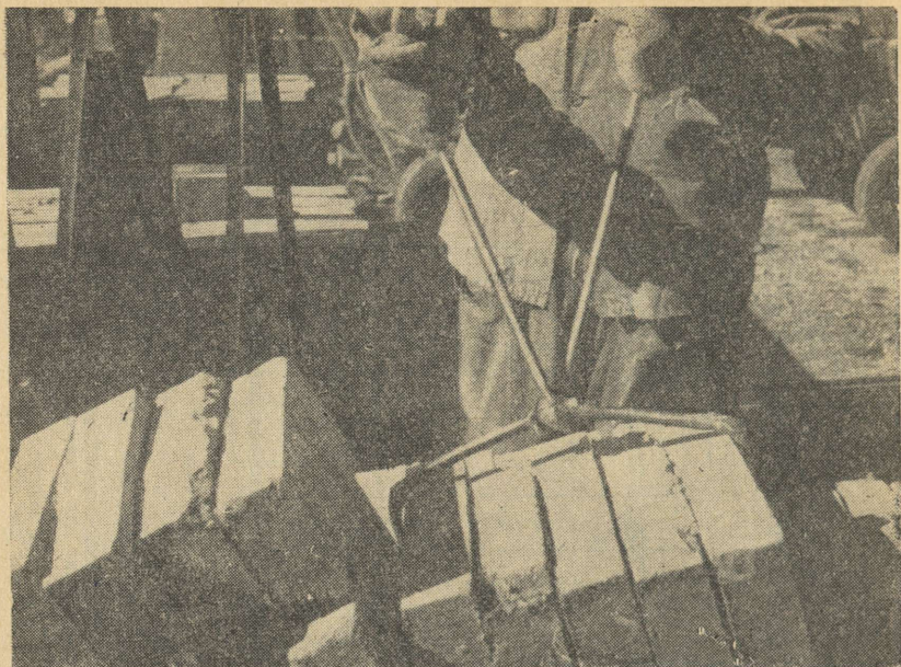
Рис. 98. Применение специальных захватов для подъема кирпичей.
