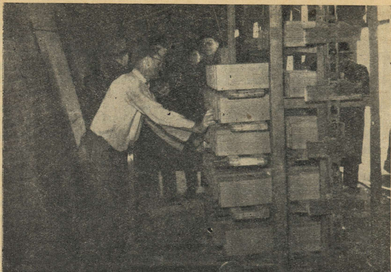
Рис. 65. Передвижной перегружатель на Готвальдовском кирпичном заводе. Перегрузка перегородочных блоков на карусельные вагонетки.
