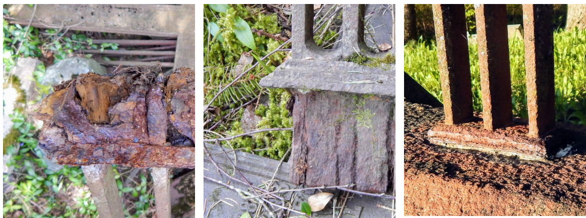
Joonis 8. Jala kinnitused kivisse.
