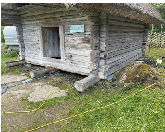
8. Hoone seisukord enne pärast tõstepunktide ehitamist. Aigar Mätliku erakogu
