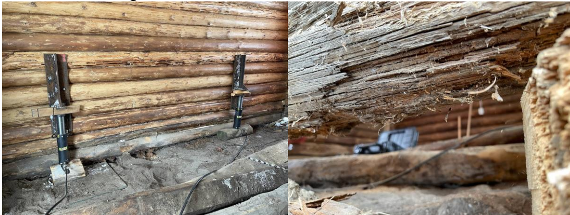
Pilt 18. Hoone tõstmisprotsess tõsterakiste ja hüdrotsilindritega. Aigar Mätliku erakogu
