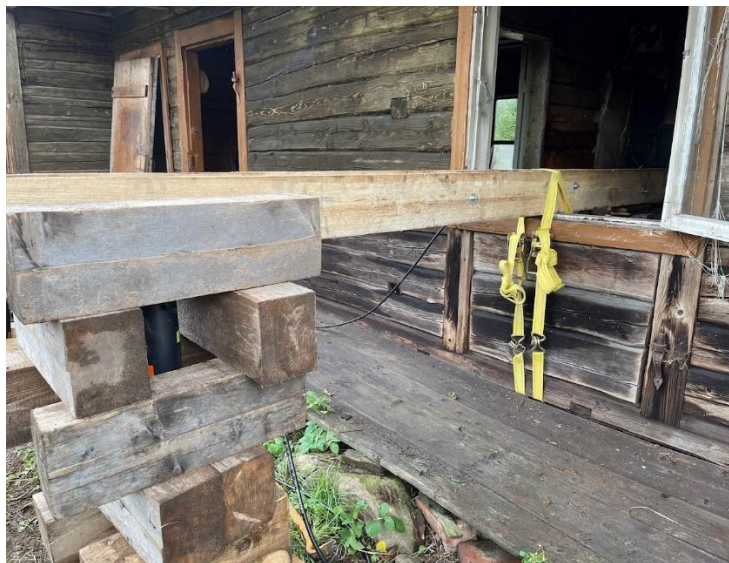
Pilt .16 Hoone tõstmisprotsess hüdrotsilindriga, prussidest ehitatud tõstepukki pealt. Aigar Mätliku erakogu
