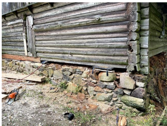
Pilt 4. Tõstepadi enne tõsteprotsessi. Vahetatav palk on parempoolne esimene palk. Aigar Mätliku erakogu
