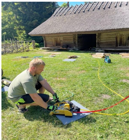
Pilt 6. Hoone tõstmine regulaatorist (juhtimispuldist.) Aigar Mätliku erakogu
