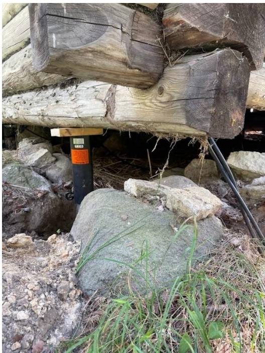
Pilt .14 Hoone tõstmisprotsess hüdro-silindriga. Aigar Mätliku erakogu
