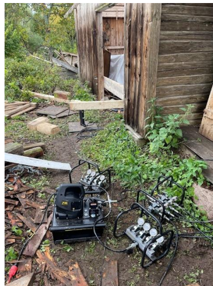
Pilt .17 Hoone tõstmisprotsess hüdrotsilindriga, Aigar Mätliku erakogu
