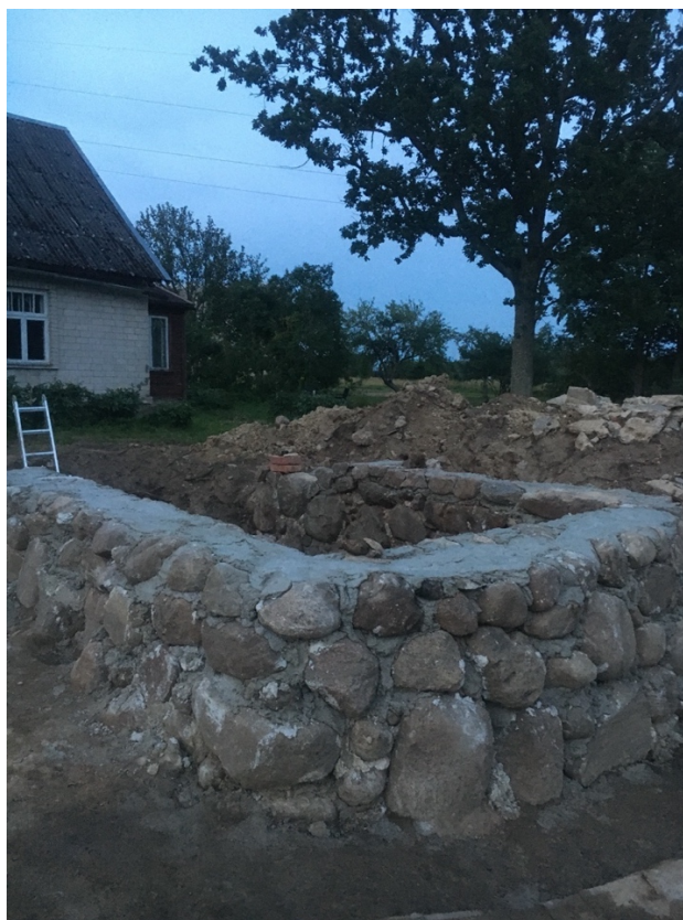
Foto nr. 15 Säilitatavate müüride ladumine (Allikas: Autori foto)
