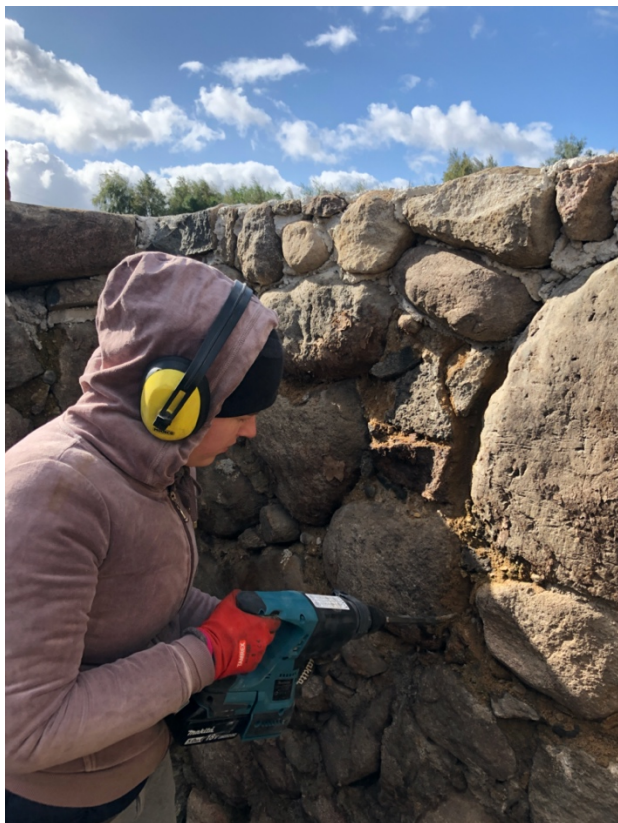
Foto nr.20 (vasakul) Vuukide piikamine ja foto nr.21 (paremal) survepesu (Allikas: Töö autori foto)
