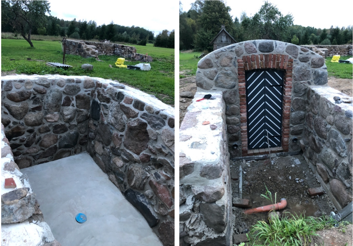
Foto nr. 23 (vasakul) ja foto nr.24 (paremal) vuugitud müürid (Allikas: Autori foto)
