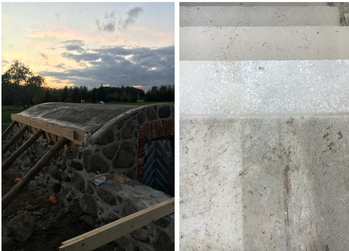
Foto nr. 31 (vasakul) valatud keldri lagi ja foto nr. 33 (paremal) Trepi viimistlus (Allikas: Autori foto)
