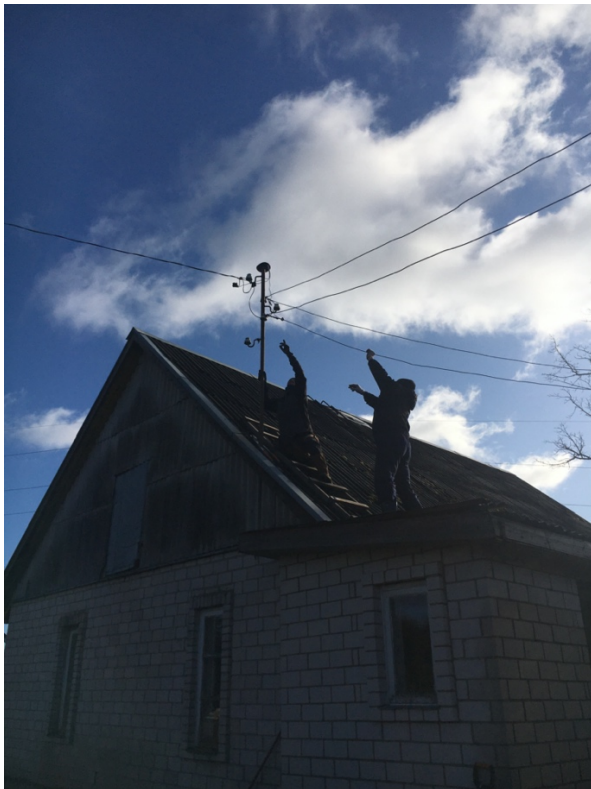
Foto nr.2 Elektriühenduse eemaldamine (Allikas: Autori foto)
