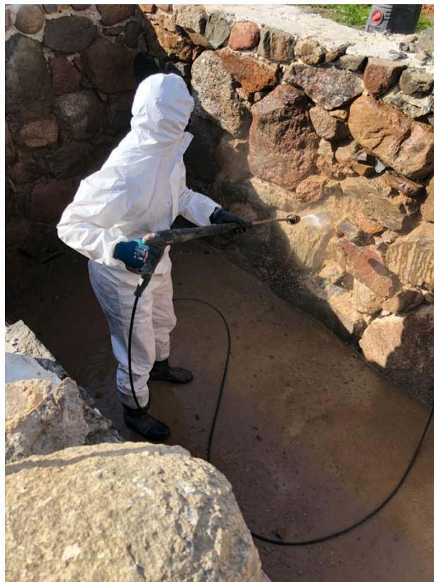
Foto nr.20 (vasakul) Vuukide piikamine ja foto nr.21 (paremal) survepesu (Allikas: Töö autori foto)
