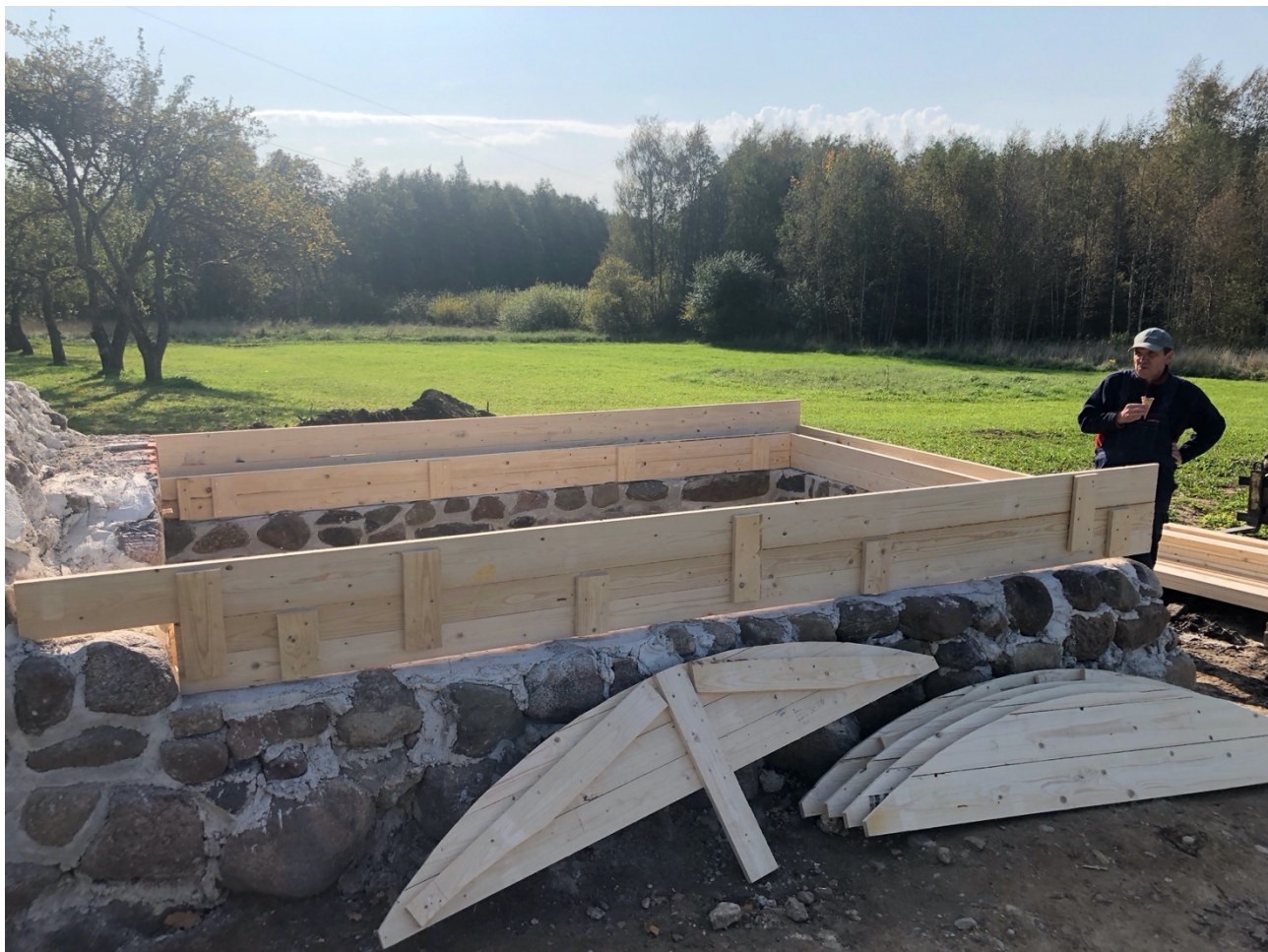
Foto nr. 25 Maakivi müüri betoonist kõrgenduse saalung (Allikas: Autori foto)
