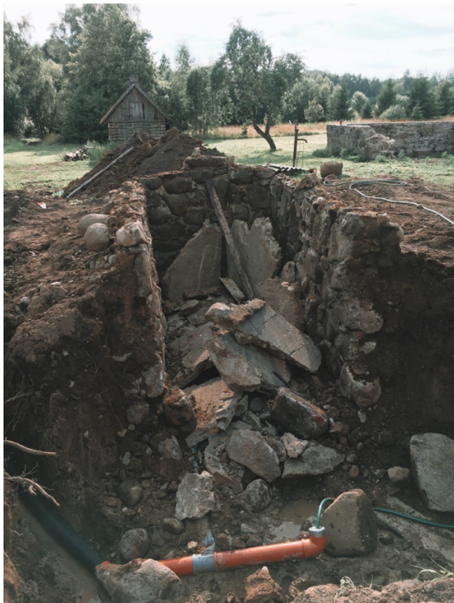
Foto nr. 8 (Vasakul) sissevarisenud lagi ja foto nr. 10 rusudest eemaldatud kelder (paremal) (Allikas: Autori foto)
