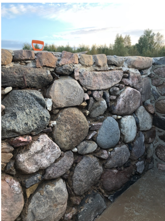
Foto nr.22 Puhastatud müür (Allikas: Autori foto)
